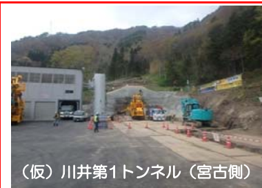
⑫施工：西松建設
