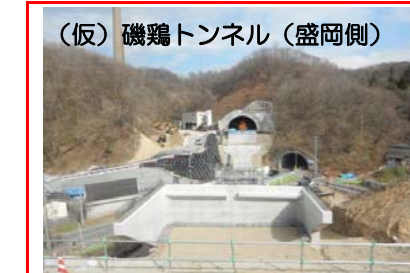
②施工：飛鳥建設
