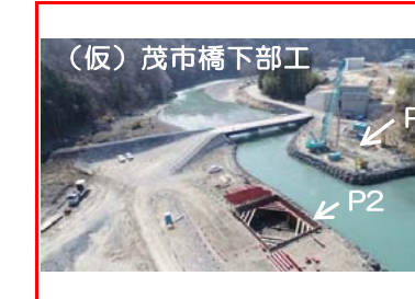
⑥施工：森本組
