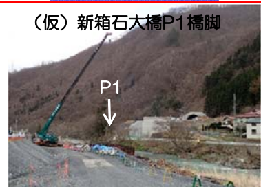
⑰施工：安藤・間
