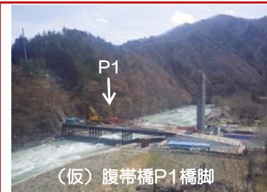
⑩施工：大豊建設
